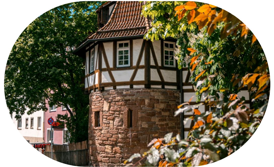
Fachwerk im Auge am Schellenturm.
