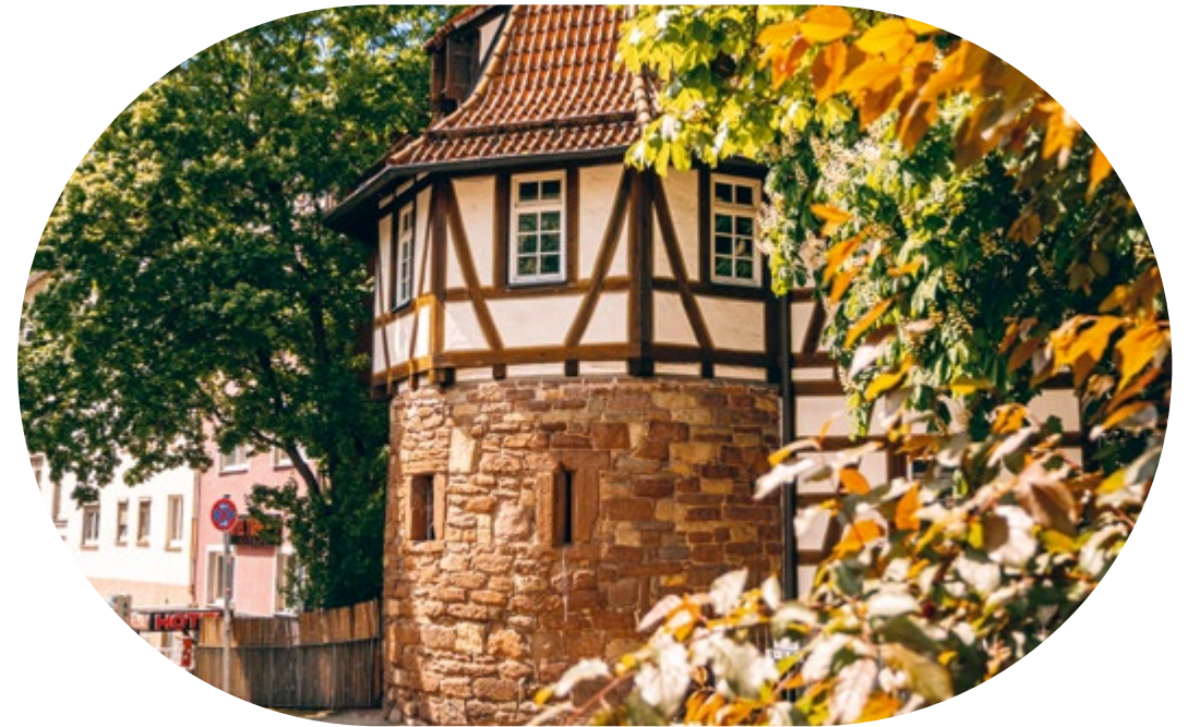
Fachwerk im Auge am Schellenturm.
